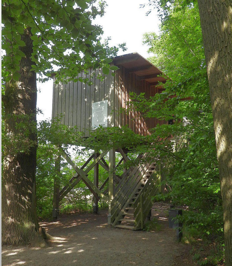
BEOBACHTUNGSPLATTFORM AM SCHAPENBRUCHTEICH
